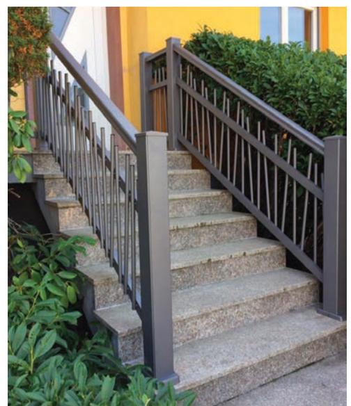
Pose sur dalle + poteaux d'angle 100x100 mm
