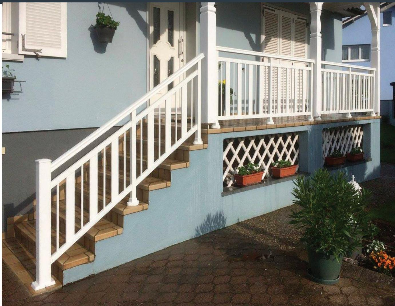
Pose sur dalle + poteaux d'angle 100x100 mm
