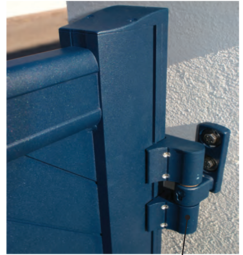
L'antidégondage se fait grâce à l'adjonction d'une paumelle sous le gond.
